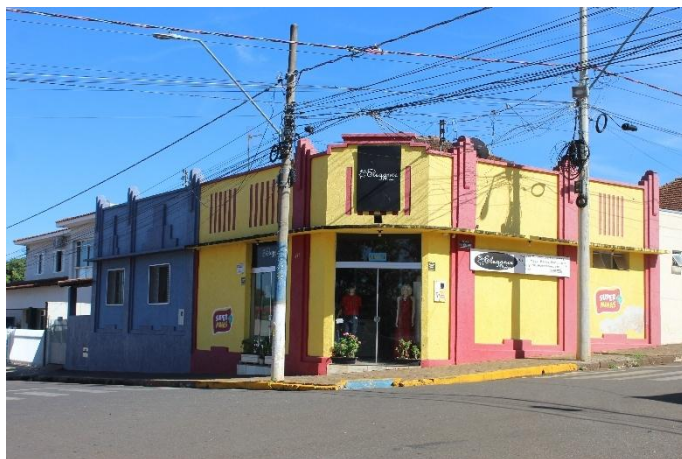
Imagem 07: Imóvel comercial localizado na Rua Galdino Cardeal da Costa, nº 694. Fotografia de Jaíne Diniz Corrêa, 12/11/2025. Área 01.
