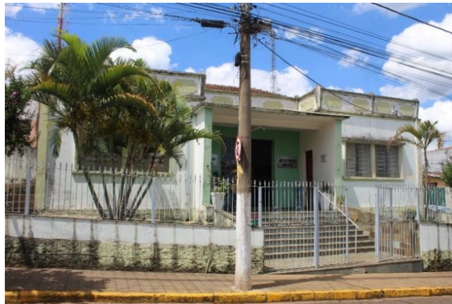
Imagem 01: Prefeitura Municipal – atual Biblioteca Municipal, localizada na Rua Wenceslau Braz, nº516, Centro. Fotografia de Luís P. Sarto, 11/112025. Área 01.
