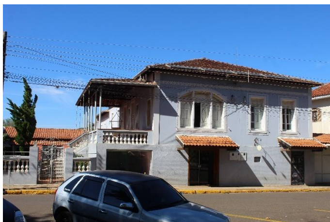
Imagem 06: Imóvel localizado na Praça São João Batista, nº 641. Fotografia de Jaíne Diniz Corrêa, 12/11/2025. Área 01.
