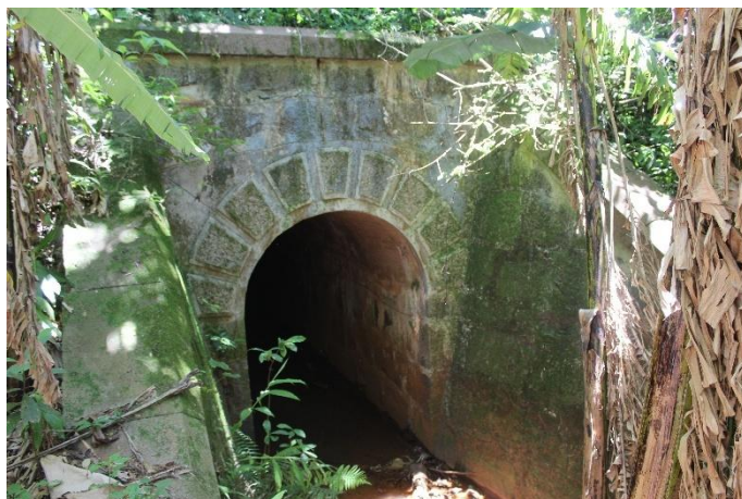
Imagem 13: Túnel do Tapir, localizado no bairro Tapir. Fotografia de Jaíne Diniz Corrêa, 12/11/2025. Área 02.
