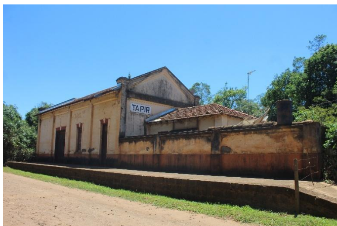
Imagem 08: Estação do Tapir, localizada no bairro Tapir. Fotografia de Jaíne Diniz Corrêa, 12/11/2025. Área 02.
