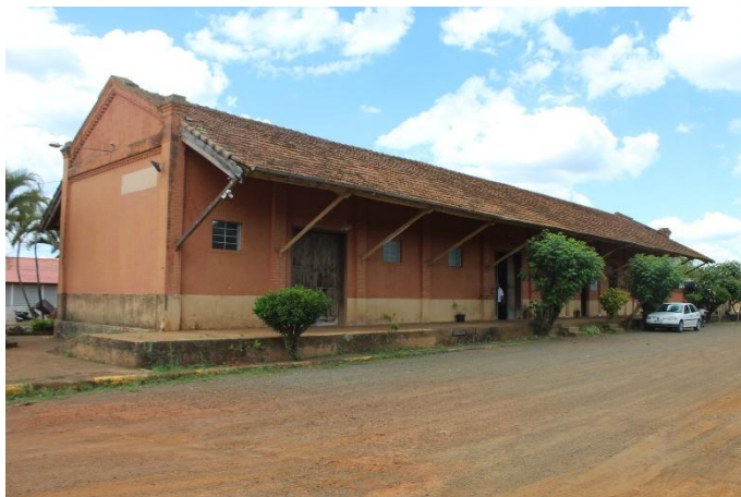
Imagem 20: Conjunto Ferroviário, localizado na Rua Waldomiro Magalhães, s/n. Fotografia de Luís P. Sarto, 11/11/2025. Área 01.
